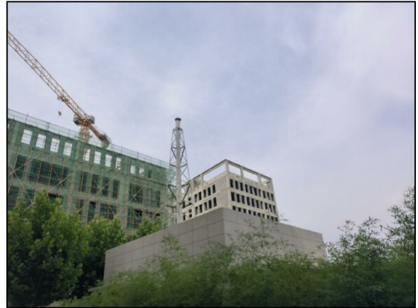
污水处理站排气筒
