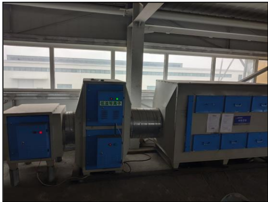
油烟净化器+低温等离子+活性炭吸附装置
