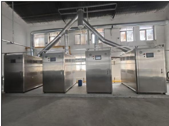
全预混冷凝直流蒸汽热源机组
