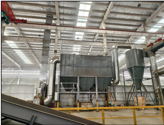
旋风除尘器+布袋除尘器
