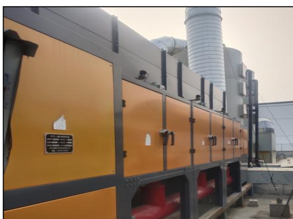
二级药液喷淋+活性炭吸附装置+催化燃烧装置
