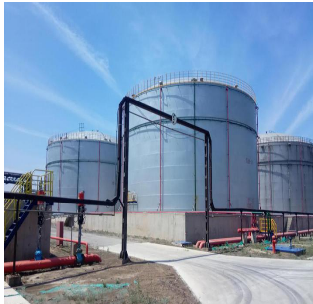
图 3-1-2 新增汽油内浮顶储罐
